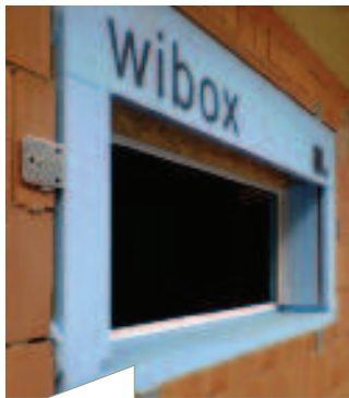
In Südtirol gelebte Praxis: Montagezargen – hier ein Beispiel von der Wolf Fenster AG.
